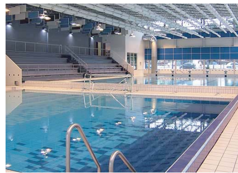
1_ La piscine St-Nicolas à Laval (53), rénovée par l'Agence Coste Architecture
