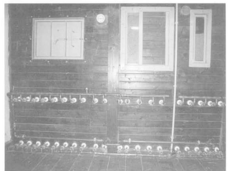
Abb. 2: Netzzellen mit Plattenheizkörpern
